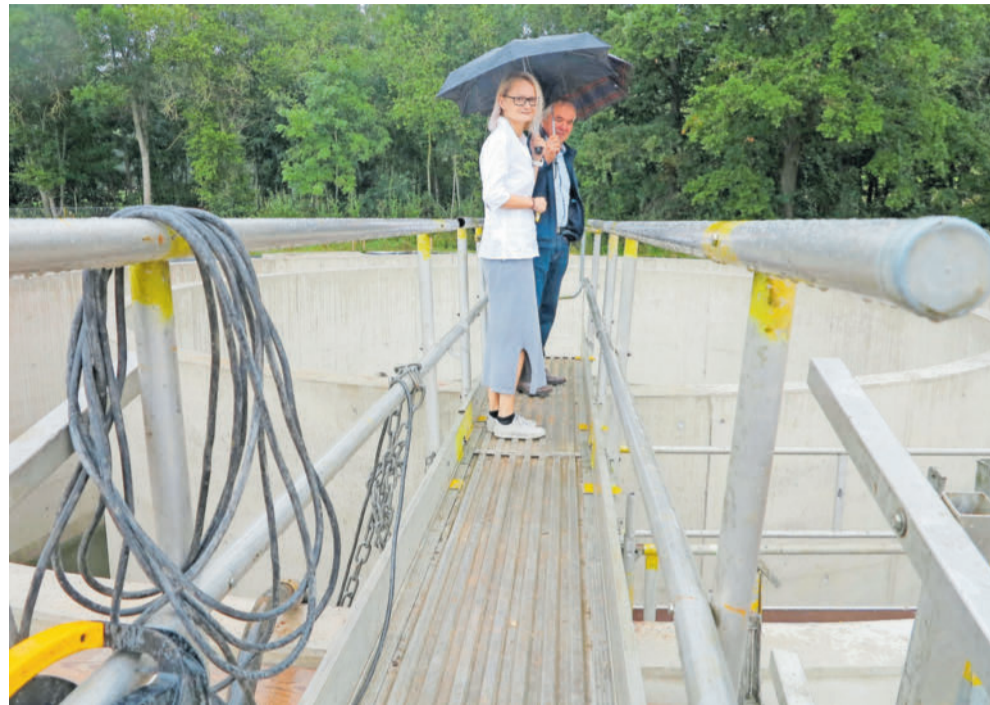
Bürgermeister Herbert Weigel und Diplom-Ingenieurin Iris Busch betätigten sich als „Schirmherren“ bei ihrem Besuch auf der Baustelle. Zum Glück war das Wetter in jüngster Zeit viel besser.
