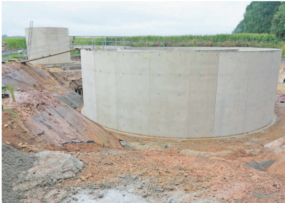
Auf der Baustelle südlich von Westheim waren in den letzten Wochen die Fortschritte unverkennbar. Große Teile aus Beton sind fertiggestellt. Der Probetrieb soll im dritten Quartal 2022 erfolgen.
